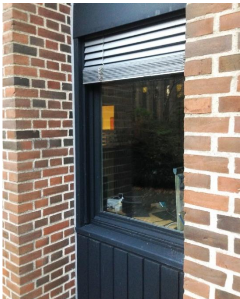
Eksempel på udvendig solafskærmning
